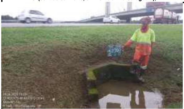
Desobstrução da manilha que atravessa a Rodovia Imigrantes, km 62(sentido sul-norte, em frente à Ilha Caraguatá);
