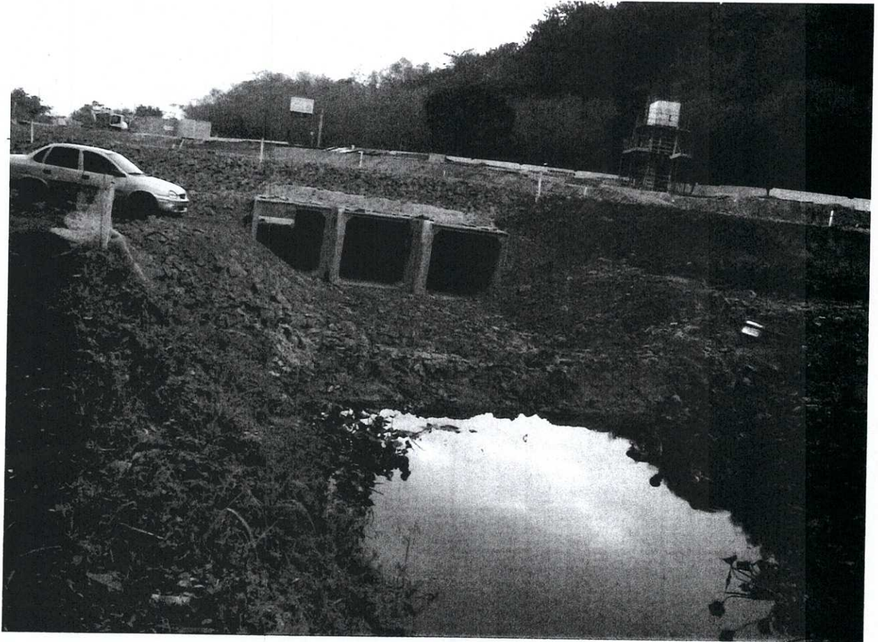
Foto 35: Aterro 01 sobre piscinão e corpo d'água sendo canalizado.
