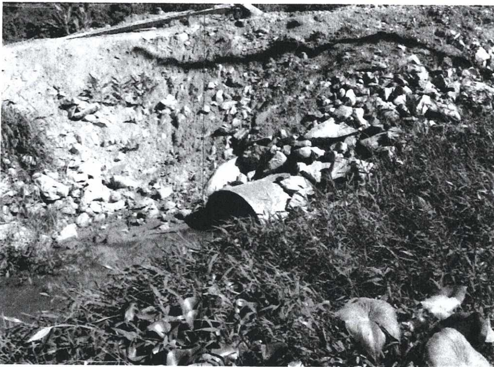
Foto 09: tubo de drenagem de 500 mm de diâmetro, a jusante da Vila Noel e a montante do Costa Muniz, instalada pela ECOVIAS.
