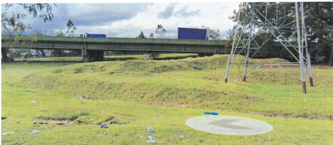
Viaduto da Vila Natal - Imagem extraída do Google Street View – Captura da Imagem: agosto de 2025 Link: https://maps.app.goo.gl/J3BzsnuAr6vZY6ka7
