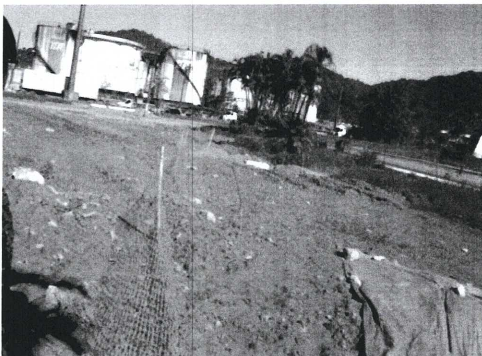
Foto 31: Aterramento da área alagadiça (ATERRO 04) entre a Rodovia Cônego Domênico Rangoni e a Av. Jornalista Giusfredo Santini, próximo a BASAN.
