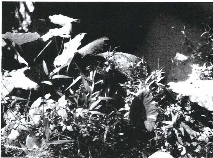
Foto 05: Saída do extravasor de drenagem do Poço de Visita da linha férrea, citado acima com 600 mm de diâmetro.
