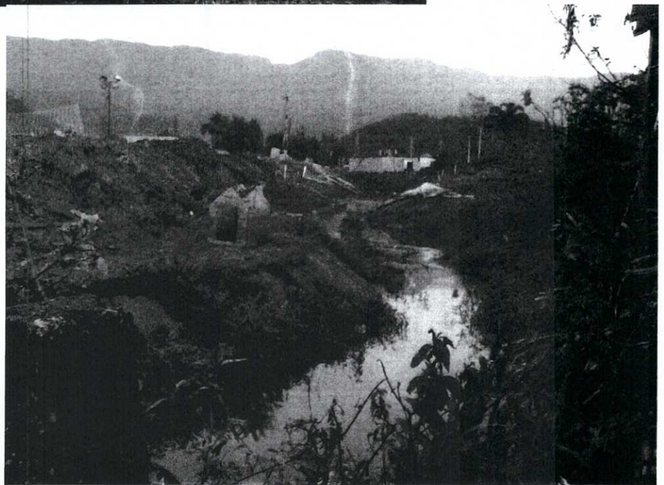
Foto 34: Crescente Movimentação de terra A margem do corpo d'água que drena uma área alagadiça (piscinão) no ATERRO 01.
