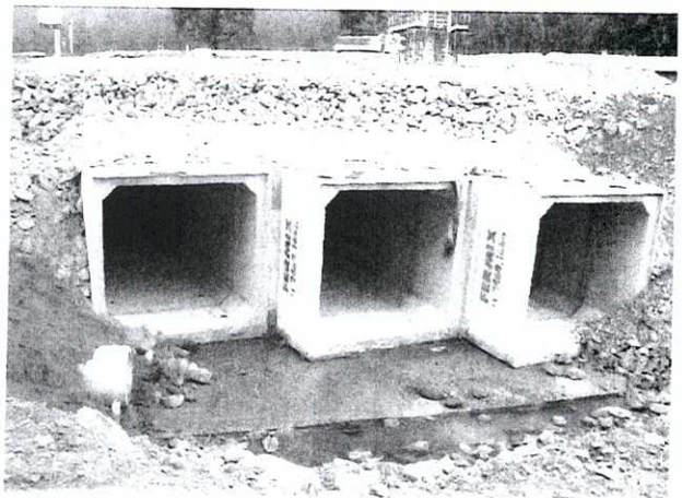
Foto 36: Detalhe da galeria implantada pela Ecovias.
