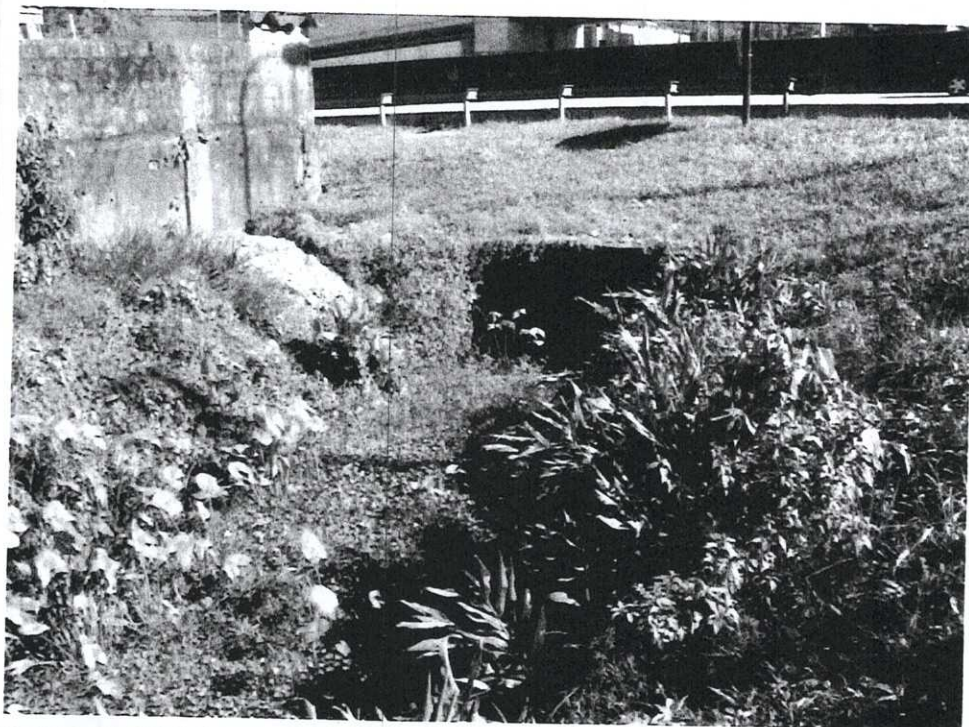
Foto 16: Canal na Vila Noel próximo a TEGMA.
