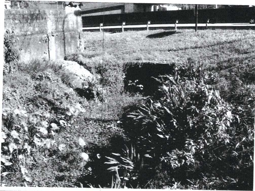
Foto 16: Canal na Vila Noel próximo a TEGMA.
