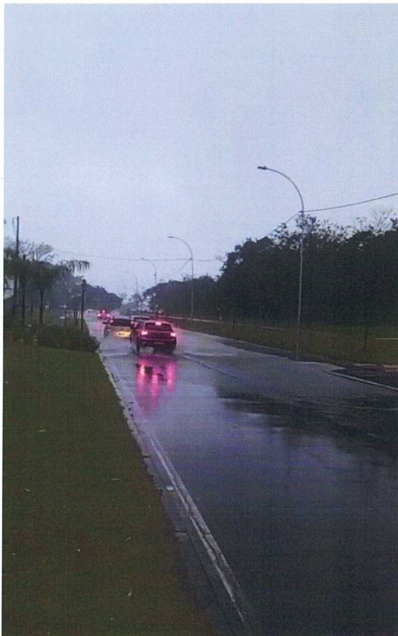
Imagem 07 – Sistema viário comprometido pelo acúmulo de água.
