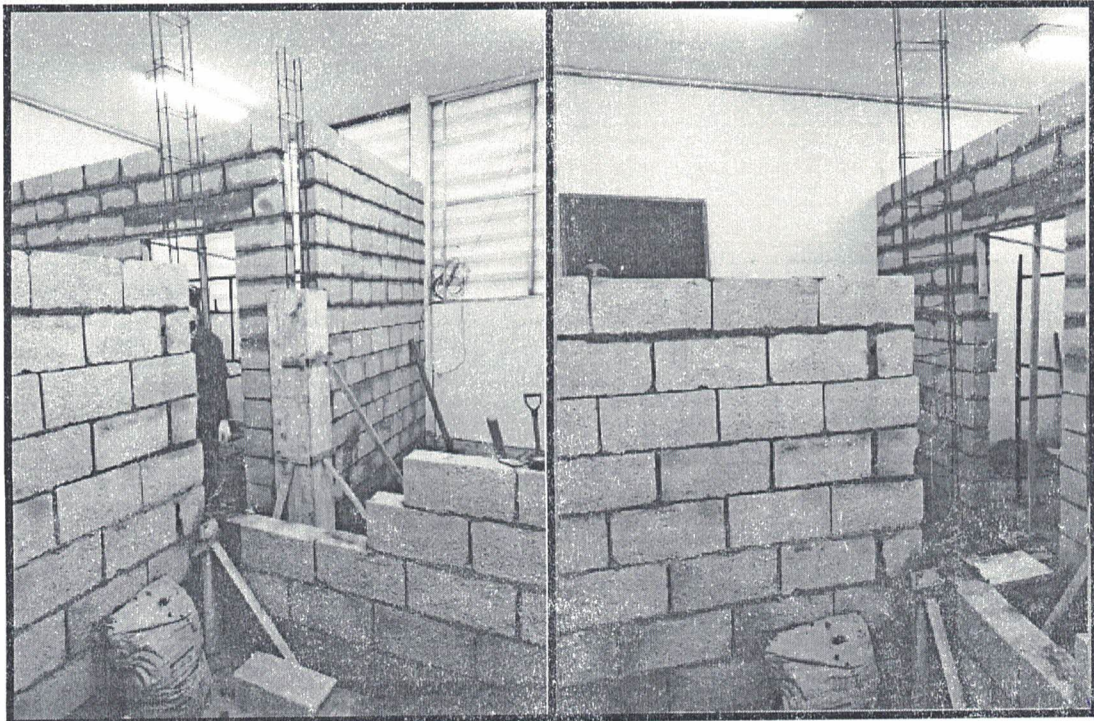
Levantamento de Alvenaria
