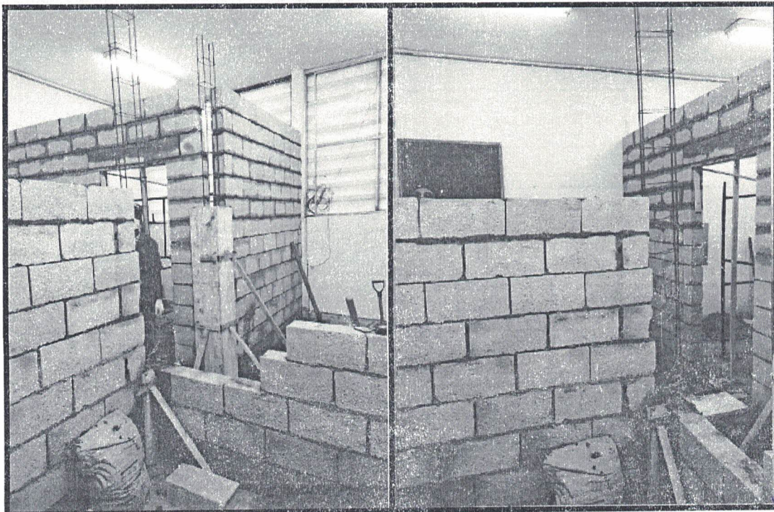
Levantamento de Alvenaria
