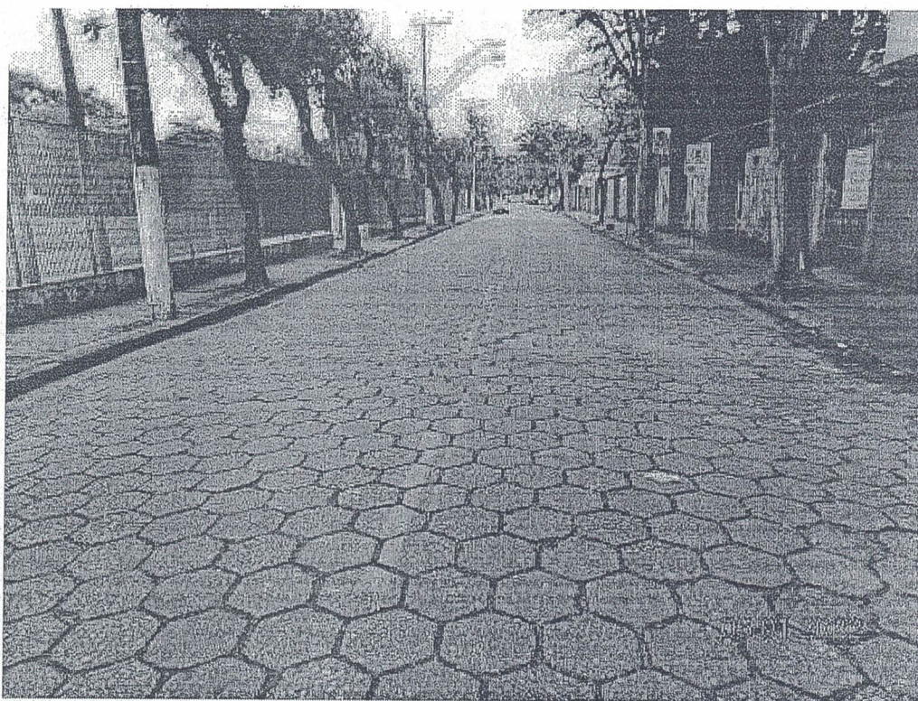
FOTO 01: Vista de trecho da Rua Bernardo Pinto; o observador encontra-se posicionado em frente ao Centro Educacional e Desportivo de Cubatão Prof. Roberto Dick, olhando em direção à Av. Dr. Fernando Costa.
