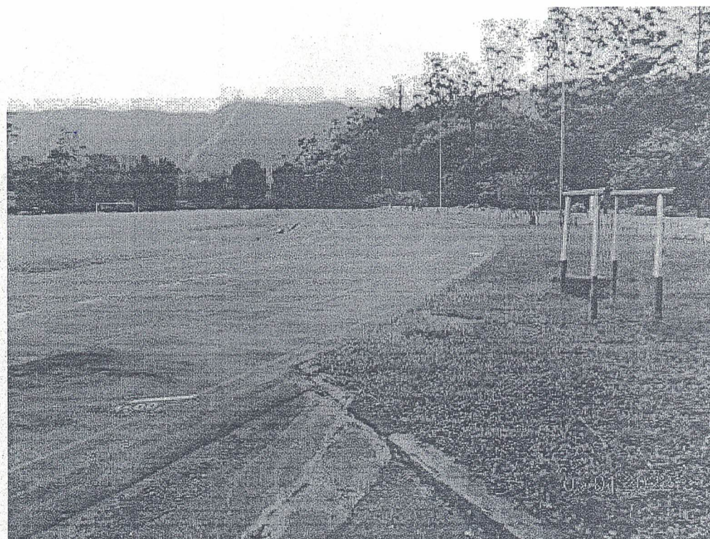
FOTO 16: Vista parcial da pista de atletismo no interior da área objeto da presente avaliação, localizada à Rua Bernardo Pinto nº 188, município de Cubatão.
